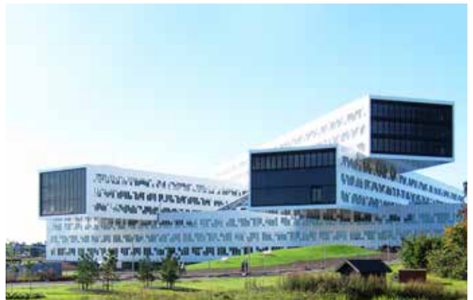
Statoil HQ - Norvège - Mini Canal
