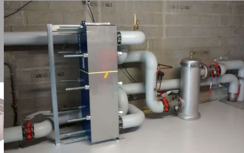
A : échangeur source CHU B : chauffage PAC
